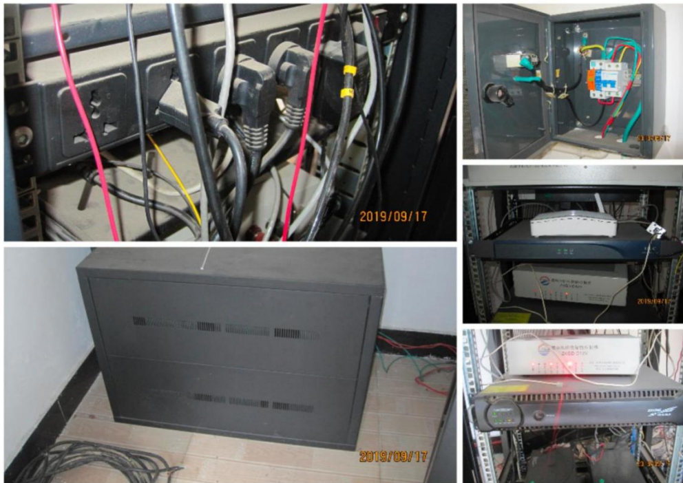
图 5.2.4 石泉流体观测站布线及配电现状
