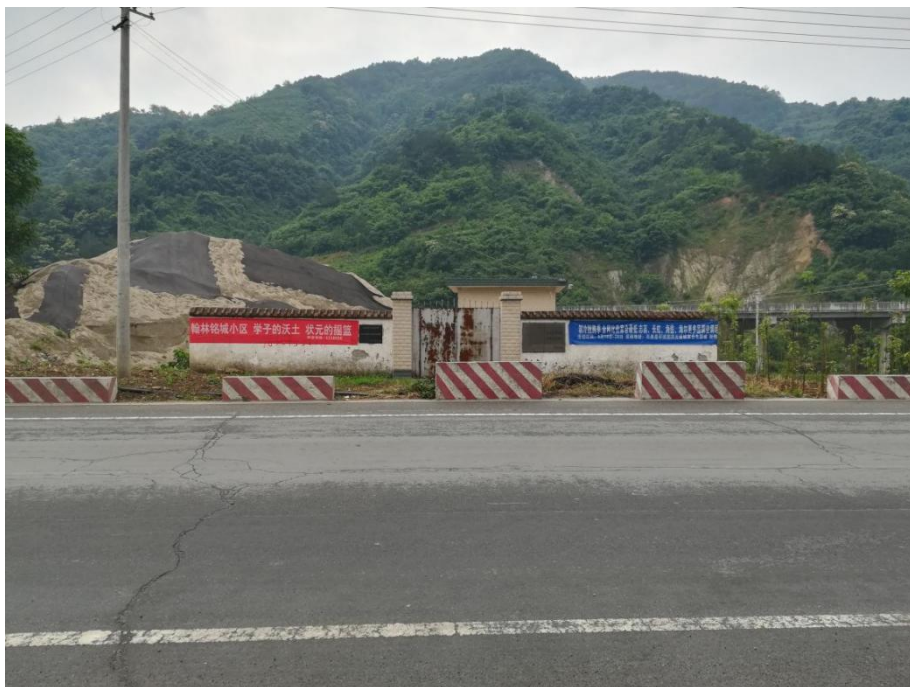
图 5.2.3 石泉流体观测站室外现状
